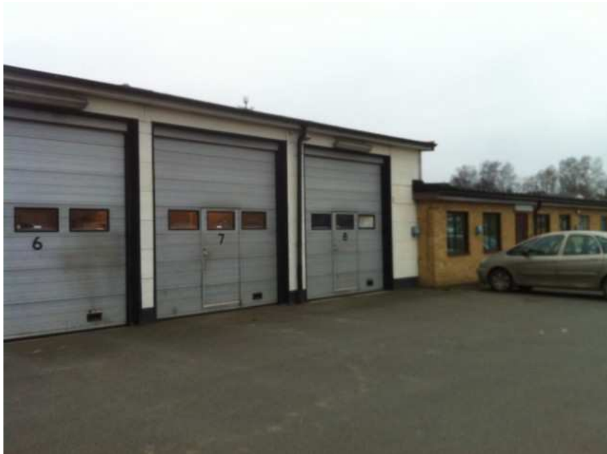
Fasad åt sydost, del med siporexfasad
