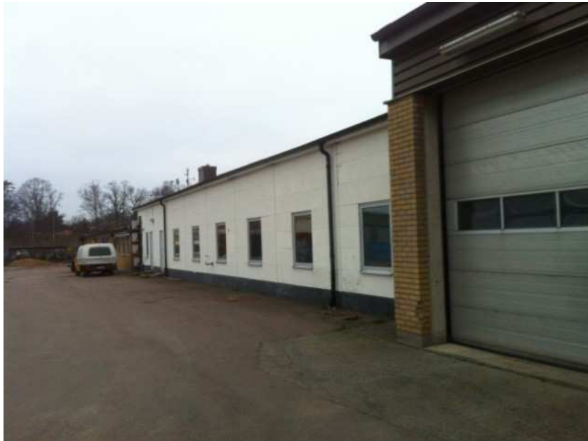
Fasad åt sydost
