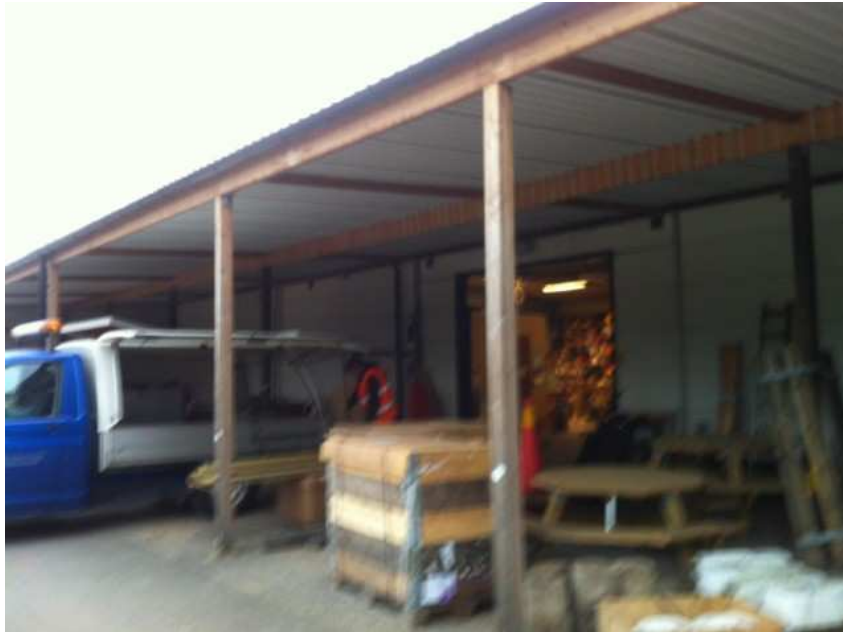
Fasad åt sydväst
