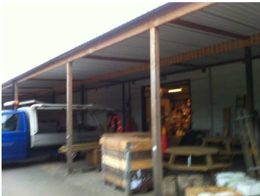
Fasad åt sydväst
