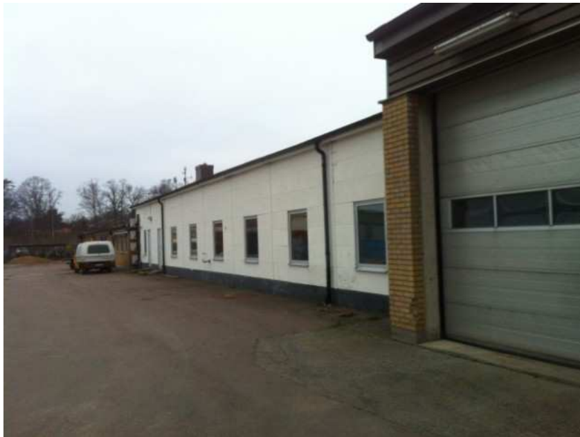
Fasad åt sydost
