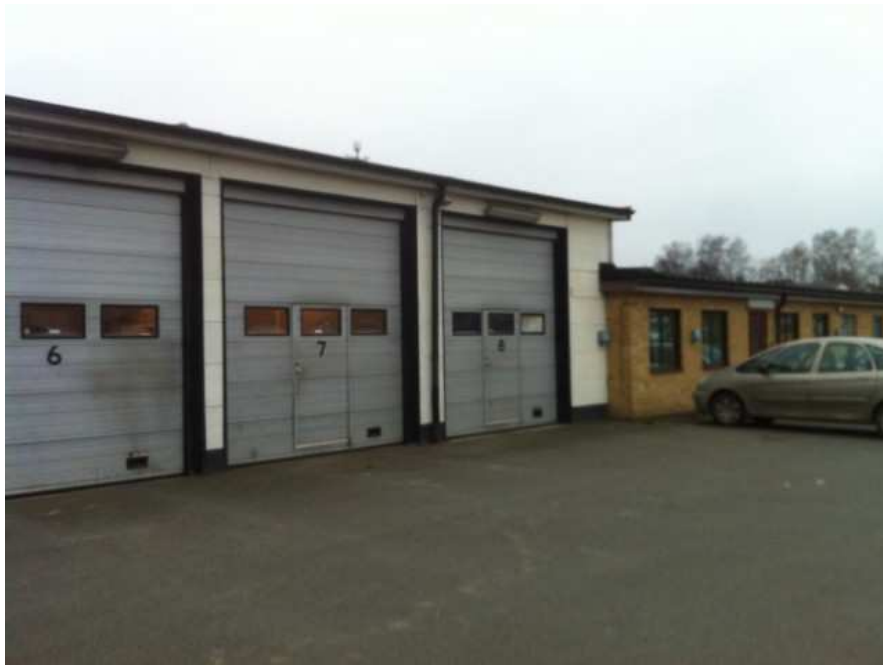
Fasad åt sydost, del med siporexfasad
