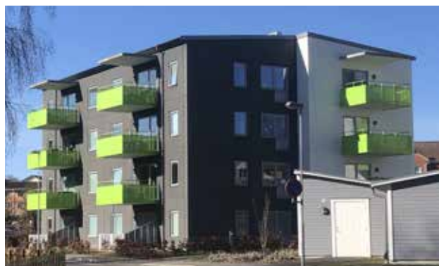
Luftigt flerbostadshus i centrala Höör
